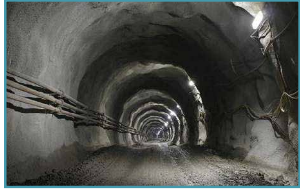
Madenlerde Püskürtme Beton Uygulaması
