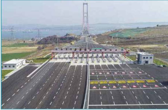
Otoyol Gişe İnşaatlarında
